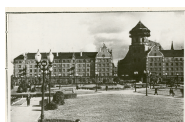
Fig. 258: Новые жилые дома с руинами церкви Святого Петра без башни на заднем плане..... 706
